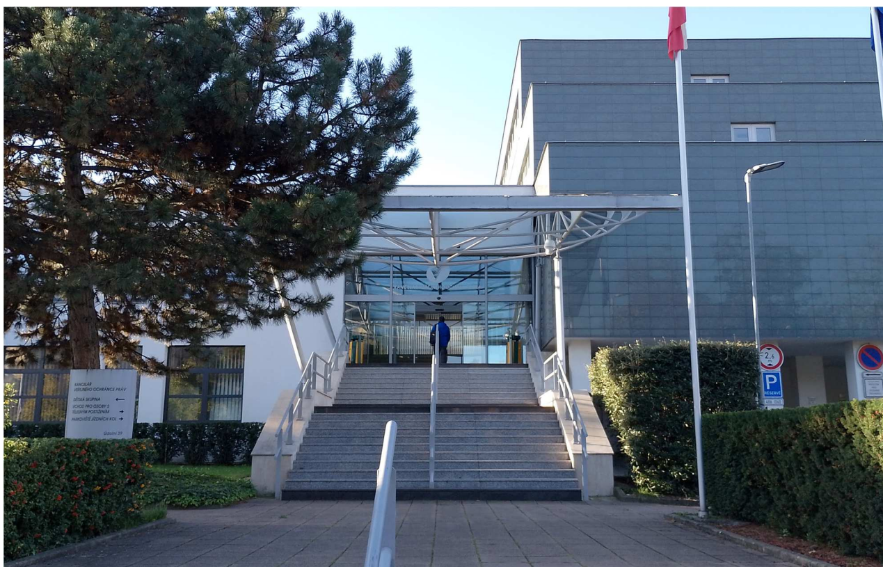
Objekt úřadu veřejného ochránce práv na Údolní 39
