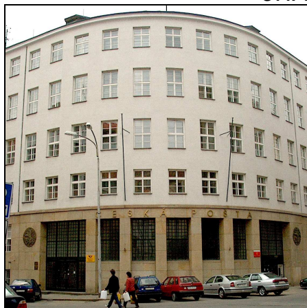
C14F2 – Průčelí objektu na Orlí (r.2002)
