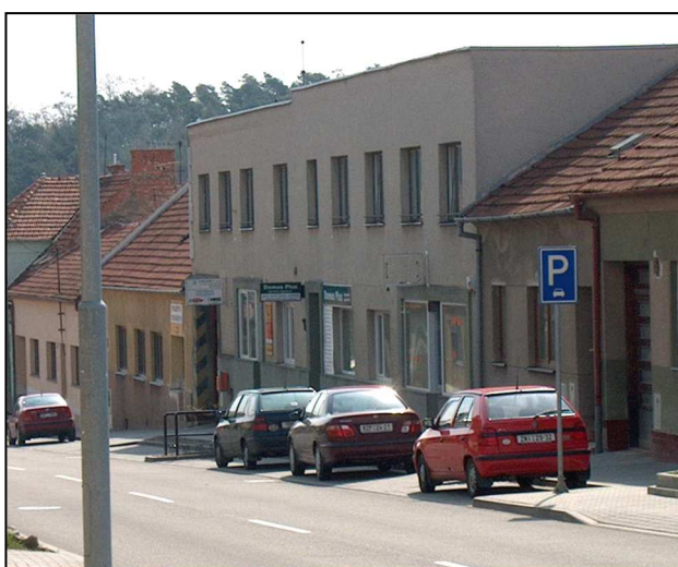
44F1 – Objekt na Odráčkově ulici, sídlo pošty Brno 45 (r. 2006)
