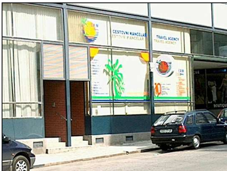
31F1 – Vlevo - prostory bývalé pošty Brno 31 v r. 2002. Opět budova od B. Fuchse (původně Moravská banka)
