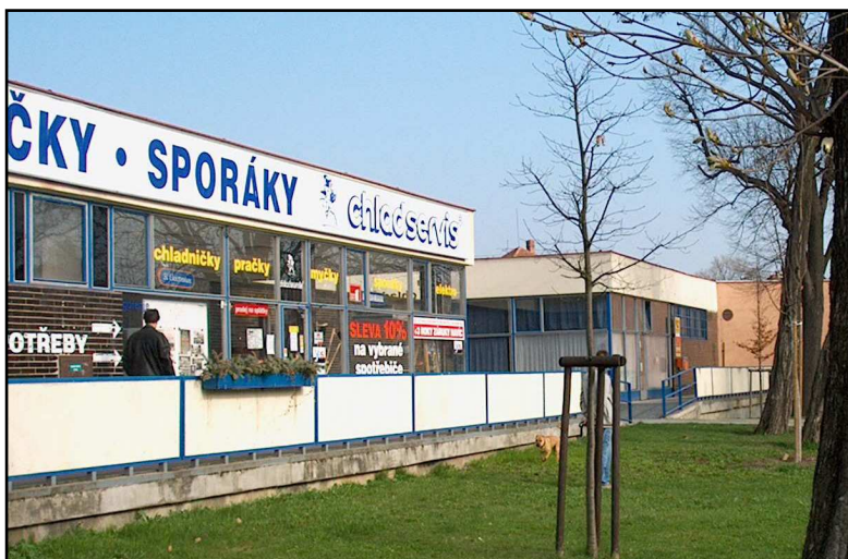
37F1 – Obchodní centrum v Jundrově, vpředu vlevo původní umístění, vzadu je vidět současnou poštu (r.2006)
