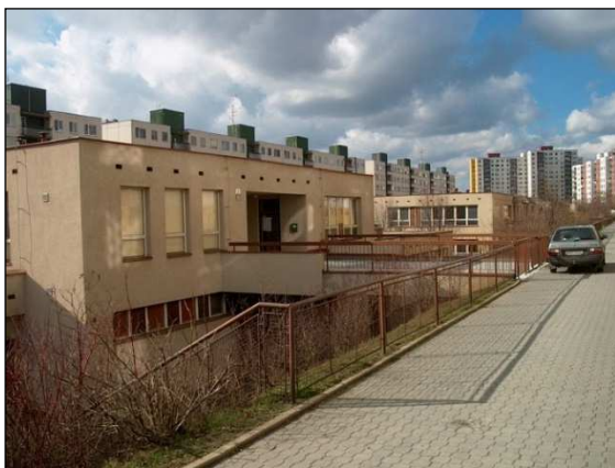
34F3 – Objekt Oblá 51 se vstupem na bývalou poštu (r.2007)
