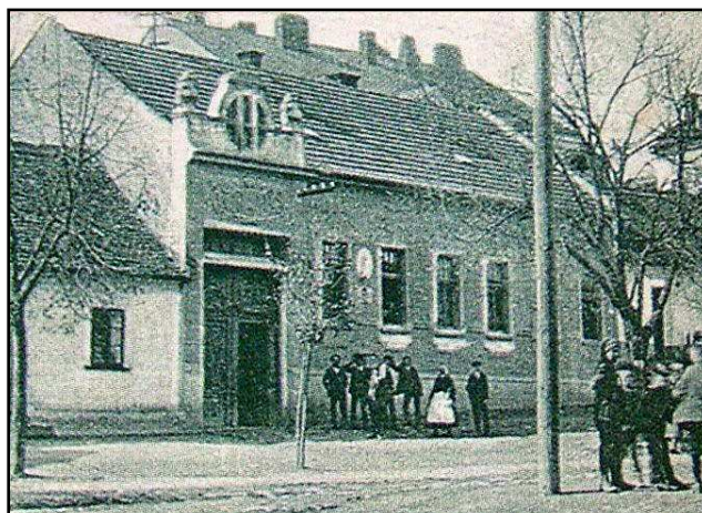
28F4 – Tento záběr stejného objektu pochází z r. 1920
