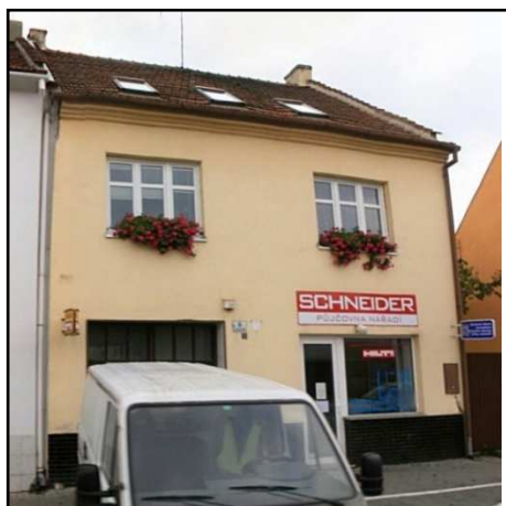
24F1 – Dnešní podoba objektu Jundrovská 8 (r.2008)
