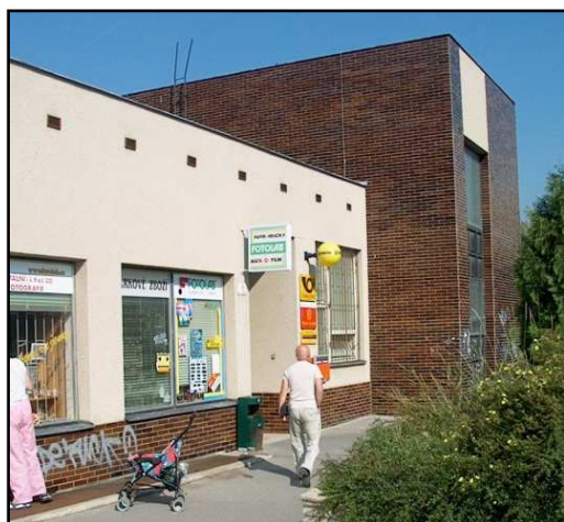
25F5 – Pošta Brno 25 (r.2008)
