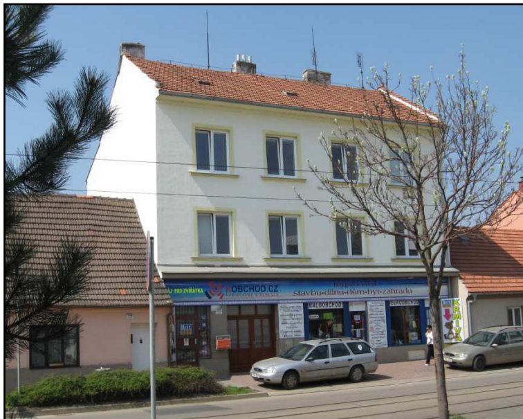
29F1 – Objekt na Selské ulici (r. 2009)
